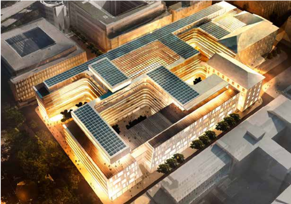
Vorzeigeprojekt: die renovierte Siemens-Hauptverwaltung in München. Hier hat Lamilux die PV-Anlage realisiert. Quelle: www.siemens.com/presse
